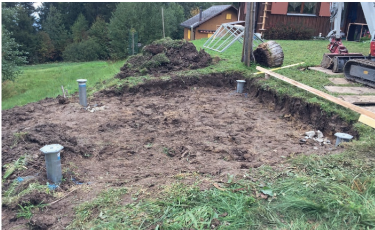
Schraubfundamente für Gartenhaus in Rüschegg BE
