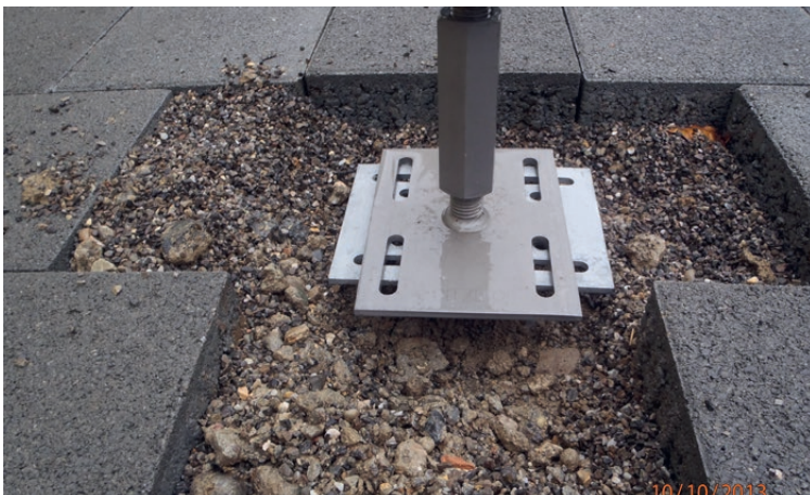
Schraubfundament mit Pfostenträger für Unterstand in Jeuss FR
