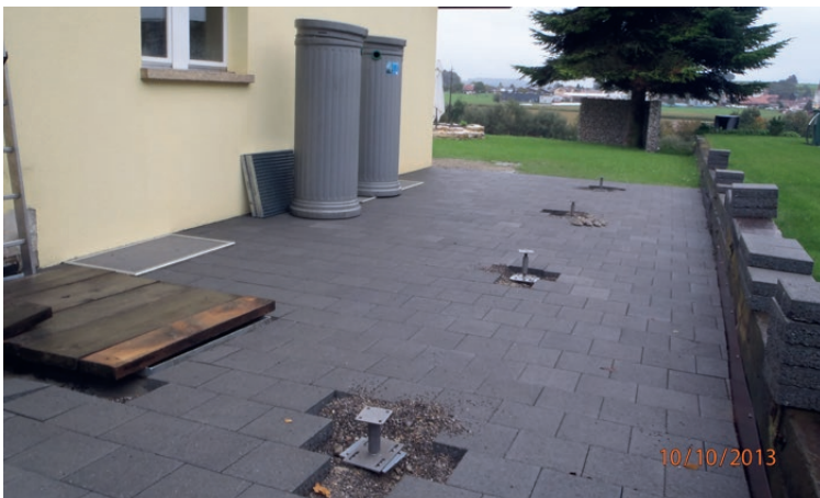
Schraubfundamente mit Pfostenträger für Carport in Jeuss FR
